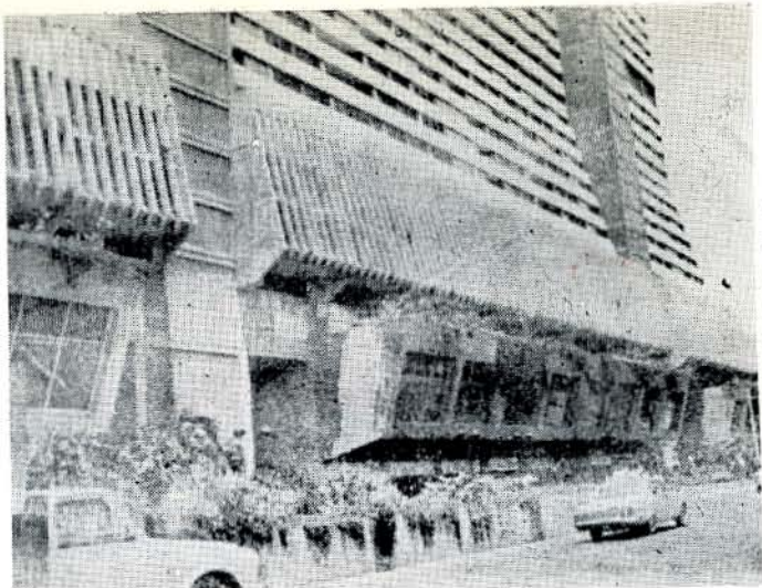
Entrada al edificio del Parque Central, donde se celebrará la Conferencia
